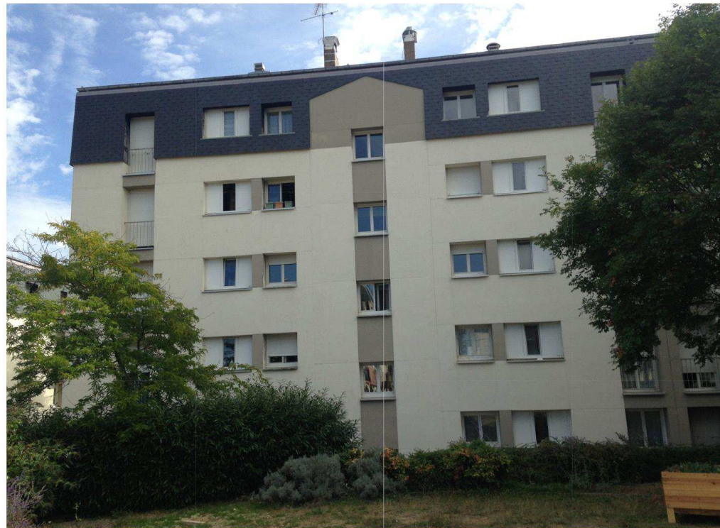
Vol 24 (façade arrière 83B)
