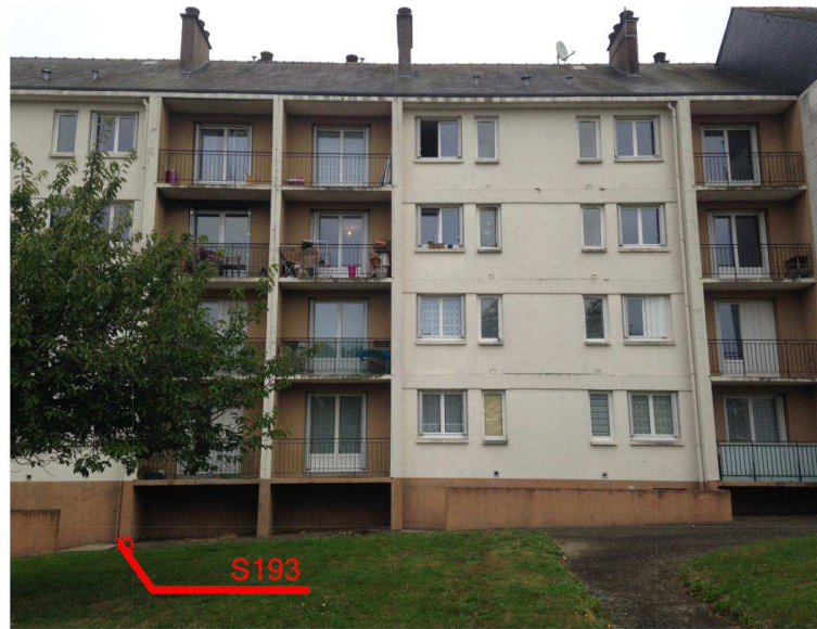
Façade arrière B2
