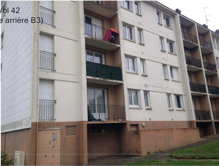
Façade arrière B3
