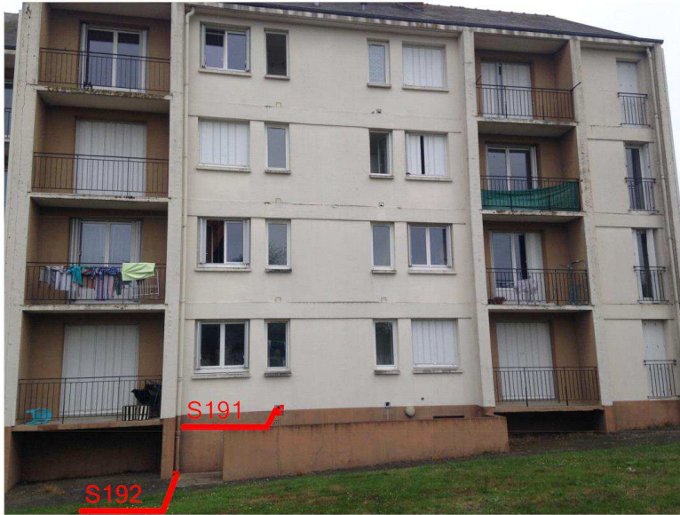
Façade arrière B1
