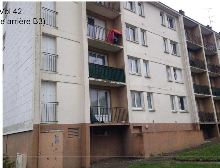
Façade arrière B3
