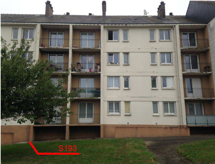
Façade arrière B2
