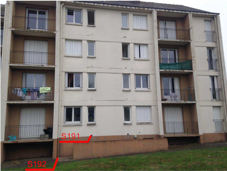
Façade arrière B1
